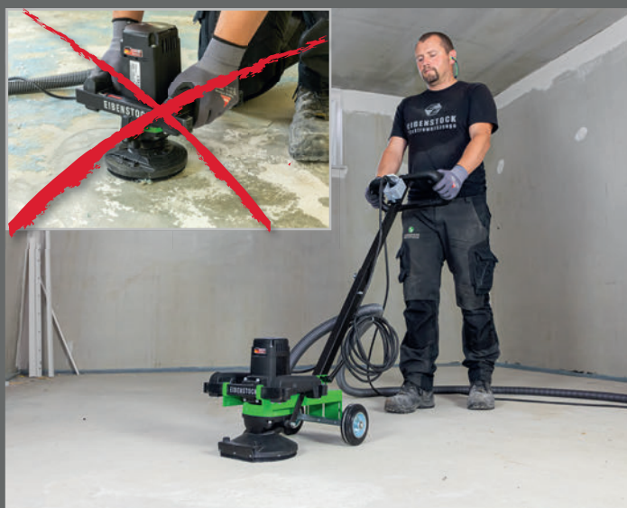
Rücken schonendes Arbeiten mit Bodenführungsgestell
