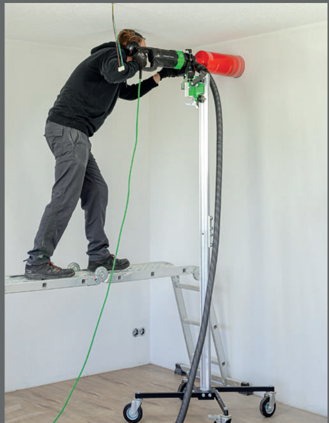
Lüftungsbohrungen bis zu 2,30 m Höhe mit Säulenverlängerung
