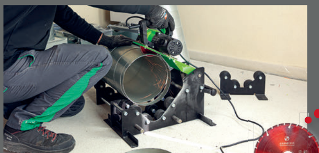
Zeitsparendes Trennen von Lüftungsrohren
